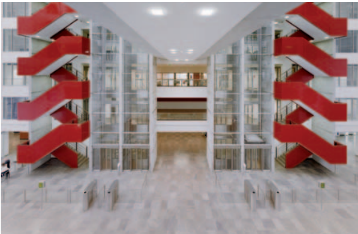
IBC Händlerzentrum Deutsche Bank: In der stark frequentierten Eingangshalle setzt der großformatige, farblich sortierte Bodenbelag aus Kirchheimer Muschelkalk optische Akzente. Die Oberflächen sind C120 geschliffen.
