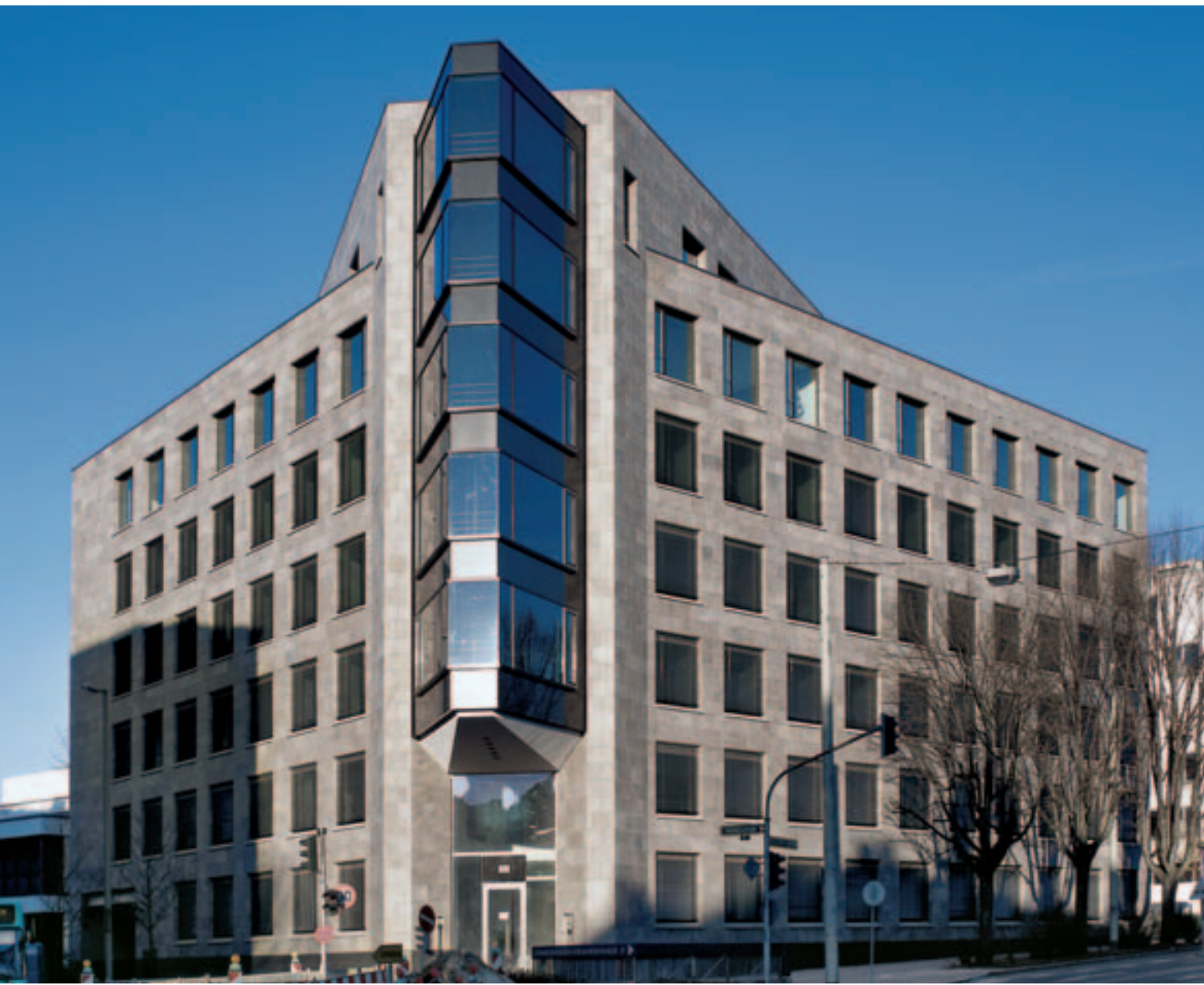
Eschersheimer Landstraße 121-123: Büro- und Geschäftshaus mit Fassade aus Kirchheimer Muschelkalk Blaues Loch im Lager. Fassadenplatten C 100 geschliffen.
